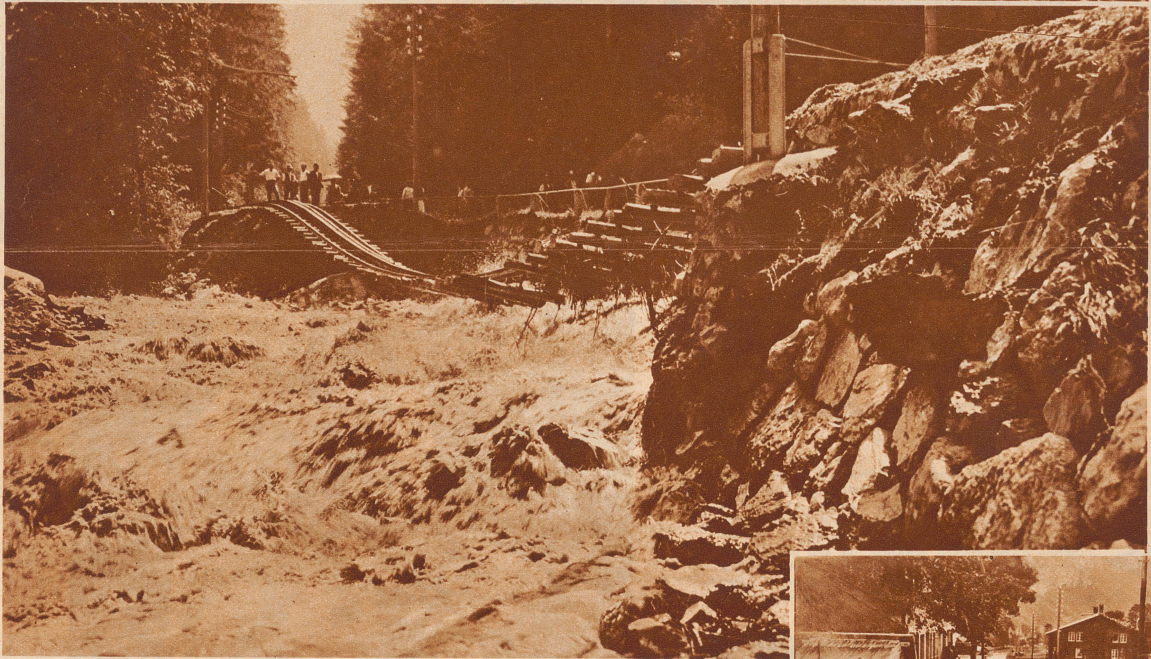
Eine Eisenbahnlinie hängt in der Luft. In der kurzen Zeit von einer Stunde hatten die Fluten der Weißen Lüttschine den Bahndamm der B. O. B. zwischen Lauterbrunnen und Zweilüttschinen radikal weggeschwemmt. Auf einer Strecke von 50 Meter hängen Schienen und Schwellen in der Luft wie eine Lianenbrücke im tropischen Urwald
