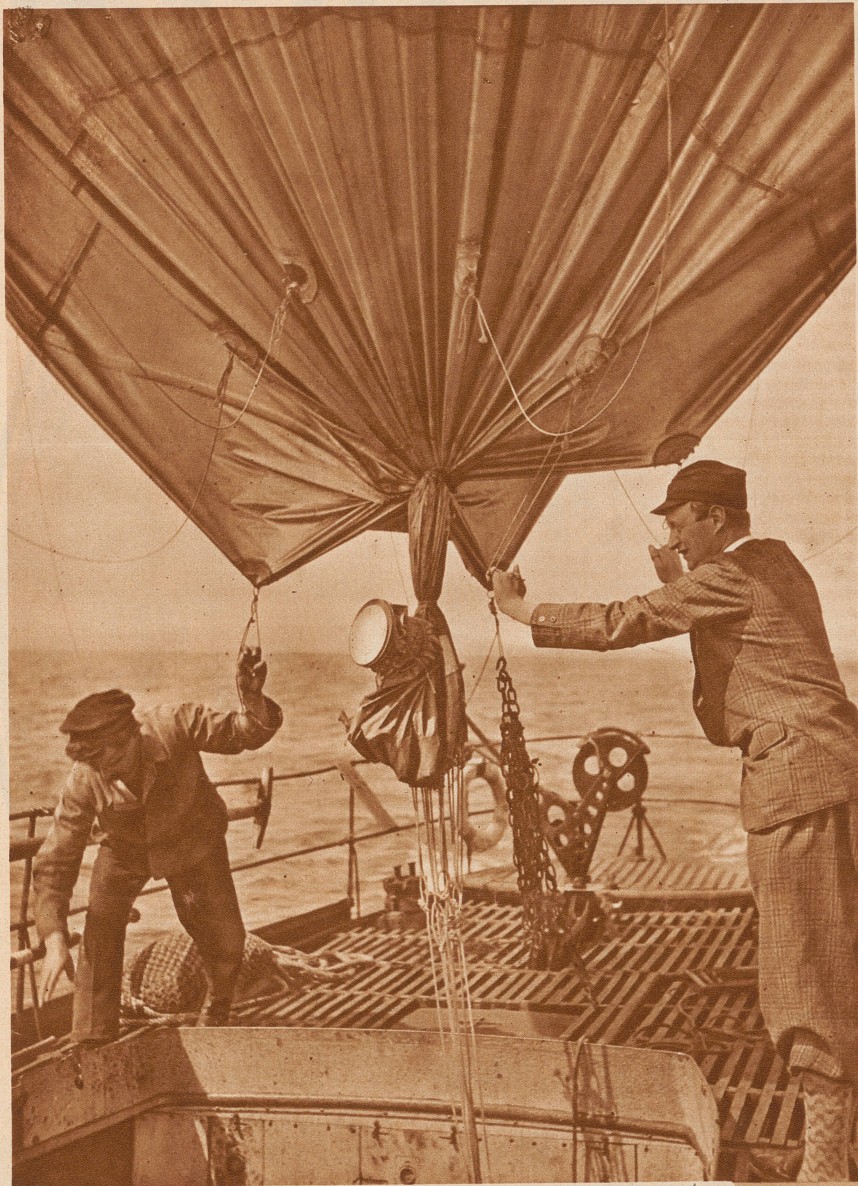
Einholen des Meßballons. Nachdem das Körbchen mit den Registrier-Apparaten vom Ballon entfernt worden ist, wird er bis zum nächsten Aufstieg in einer Versenkung des Schiffes verankert
