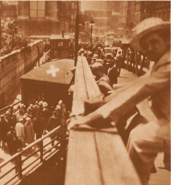
Die Krawallbrüche die Solla, wo Jake Lighe, der Kriminal-Reporter der «Chicago Tribune», am hellen Nachmittag niedergeschossen wurde.
