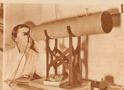
Die Untersuchung des Destillates erfolgt, nicht nur chemisch (durch Titration), sondern auch mit einer optischen Methode. Unser Bild zeigt die Interferenzmethode, in welcher das Blutdestillat auf seine optischen Eigenschaften geprüft wird. Aus dem optischen Verhalten läßt sich der Alkoholgehalt berechnen
