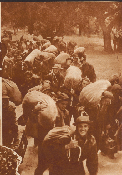
Zum Bild der amerikanischen Arbeitsschlacht gehören auch die Arbeiter als eine Form der Verwirklichung des proklamierten Rechts auf Arbeit. Eine Gruppe bringt Leinwand, von 18 bis 25 Jahren ist unterwegs nach einem Arbeitgeber in Kalifornien, wo sie beim Bau neuer Bahnhöfen, Straßen, Dämme etc. beschäftigt werden.
