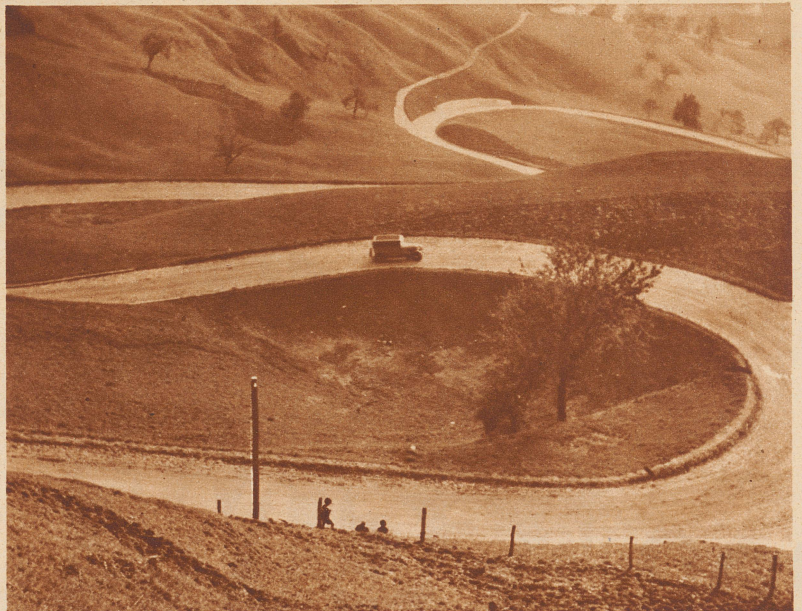
Die neue Pafwangstrafe dem Verkehr übergeben. Nachdem dieser Jura-Uebergang bei den Herbstmanövern eines Teils der 4. Division seine Feuerprobe bestanden und sich in jeder Beziehung bewährt hat, wurde in diesen Tagen die Straße dem Verkehr übergeben. Bild: Die kurvenreiche nördliche Zufahrt zum 175 Meter langen «Zingelen»-Tunnel. Aufnahme Leemann
