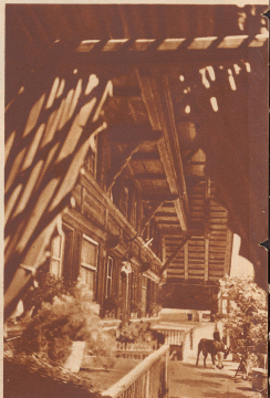
Der Renner Bauer baut sich nicht nur ein zweckmäßiges, sondern auch ein schönes Haus, in welcher traditioneller Bauweise. Ein solches Gebäu mit gepoltem Strohplattens trägt das wuchtig überstehende Dach. Das Gebäu wurde 1796, als die Frauen aus Land warrten, von Joh. Oberli neu erbaut.
