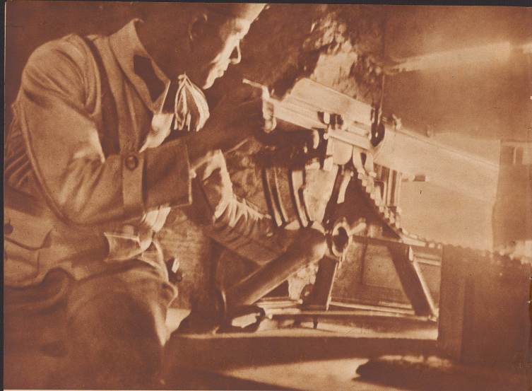
Maschinengewehrstellung im Dachboden eines Privathauses dicht an der österreichisch-deutschen Grenze.
