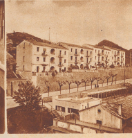
Eine Reihe Arbeiterhäuser, die die Firma bauen ließ. Die Häuser sind der Gegend angepasst, die Wohnungen hygienisch einwandfrei. Die Miete beträgt für eine Vierzimmerwohnung 3,50 Pesetas im Monat. Die Farga zahlt auch für die Arbeiter. Eine Zweidrittel der Arbeiter wohnen in den Häusern der Firma.
