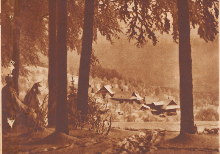
Wenn der Wanderer im letzten Viertel seiner Gratwanderung einen Durchblick auf die verstaubte Hütergruppe wirft, dann soll er auch den Schwefelhof vor sich wissen. Da ist ein Oberhalb bei Hütten.
