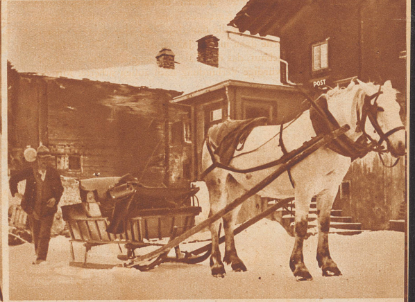
Eine Einspänner-Schlittenpost vermittelt den Bewohnern von Cresta die Verbindung der Außenwelt. Alles, was diese Menschen zum Leben nötig haben, wird mit diesem Schlitten in täglich fünfständiger Fahrt vom Tal heraufgefahren. Eine Bäckerei beispielsweise gibt es in Cresta nicht. Der Brotbedarf des Tales wird von auswärts gedeckt, die Postverwaltung übernimmt den Transport zu Spezialtarifen.
