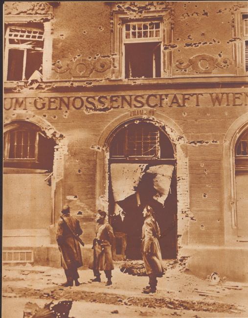
Das zerstörte Gebäude der Kosungsgenossenschaft in Ottkring.
