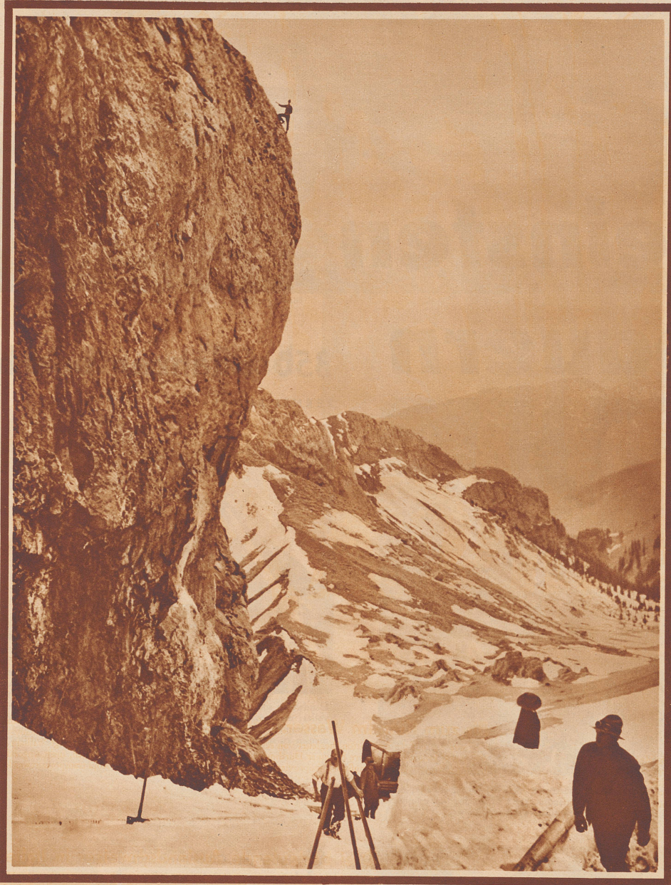
Das in die Rinnen und Ritzen der Felsen eindringende und im Winter gefrierende Wasser lockert das Gestein, und so besteht immer im Frühjahr Steinschlaggefahr. Um die Bahn davor zuverlässig zu schützen, muß ein bergtüchtiger Mann sämtliche das Geleise überragenden Felswände Quadratmeter um Quadratmeter nach lockeren Felsstücken abtasten und die gelösten Teile in die Tiefe befördern.
