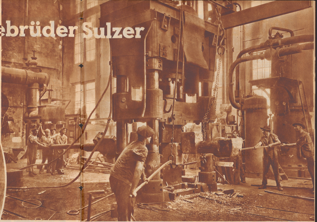
Ans den Sulzer-Werkstätten in Winterthur. Hydro- und Schmelzmaschine von 1000 Tonnen Druck, zum Schneiden von Kurbelwellen und andern großen Stücken
