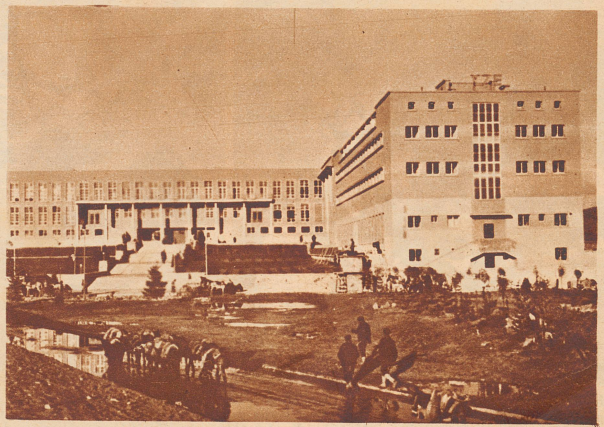
Gesamtansicht der Landwirtschaftlichen Hochschule von Ankara. Ein moderner Bau in jeder Beziehung. Viele Fenster machen jede andere Aufteilung der monumental Front überflüssig. Licht, Luft, Geräumigkeit, Uebersicht sind die ersten Prinzipien der Anlage.
