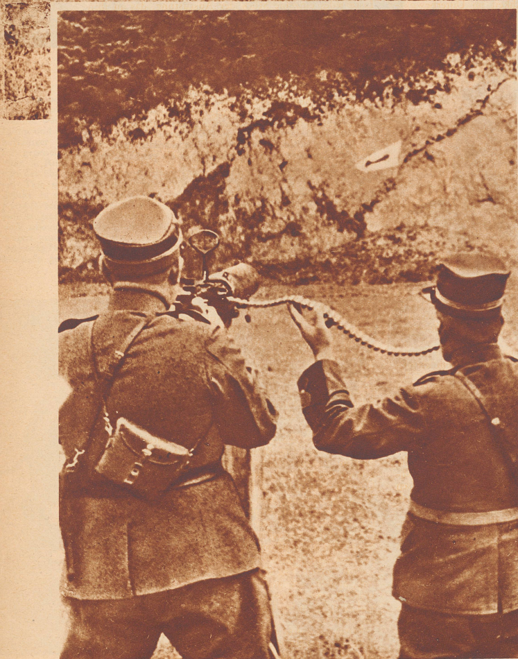
Schießen auf bewegliche Flugzeug-Ziele. Mittels eines Haspels wird die Flugzeugscheibe mit beträchtlicher Geschwindigkeit auf eine Distanz von über 100 Meter vor dem Maschinengewehr vorübergezogen. Der Schießende visiert das Ziel an und feuert, jedoch ohne dem Flugzeuge mit der Visier-Linie, d. h. mit dem Maschinengewehr zu folgen. Gleich die erste Schießübung ergab ein Resultat von 4 Treffern im schwarzen Flugzeuge selbst und 7 Treffern im weißen Teil der Scheibe.
