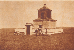
Burjatischer Lama-Tempel mitten in der mongolischen Steppe. In einem Labyrinth von zweihundert Kilometer ist es das einzige Gebäude. Die Bauart weist eine Verbindung buddhistischer und muslimischer Stile auf. Vor dem Tempel die Kathedrale des Bischofs von Chelien.
