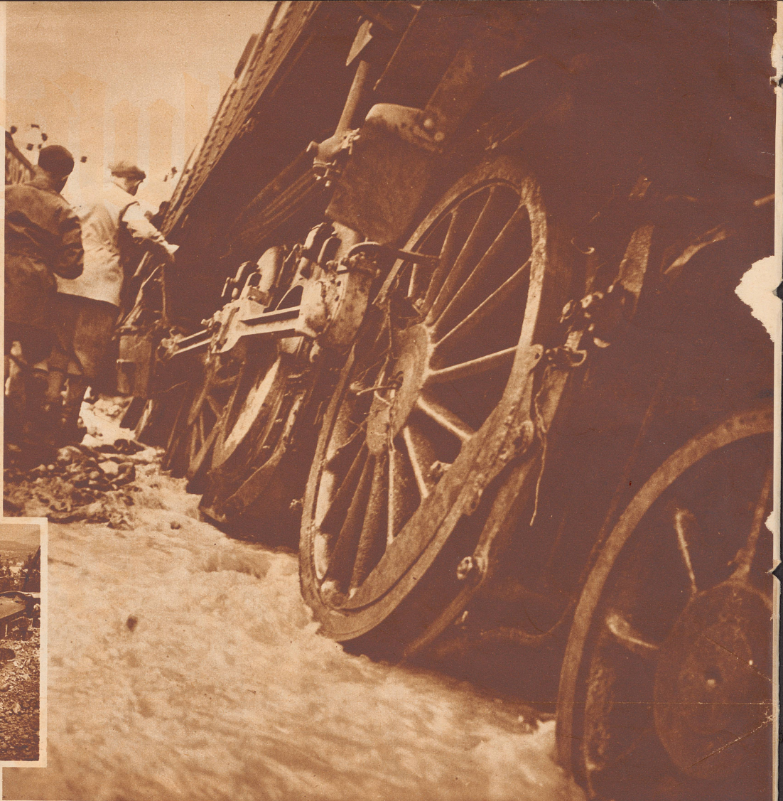
Die Lokomotive des verunglückten Zuges war von den niedergehenden Felsen und Erdmassen aus dem Geleise gedrückt und auf der Bergseite völlig zugedeckt worden. Auf der andern Seite stehen die Räder im Wasser. Ein paar Meter weiter – und die Lokomotive wäre über einen steilen Hang 30 Meter abgestürzt. Der Lokomotivführer wurde verletzt.
