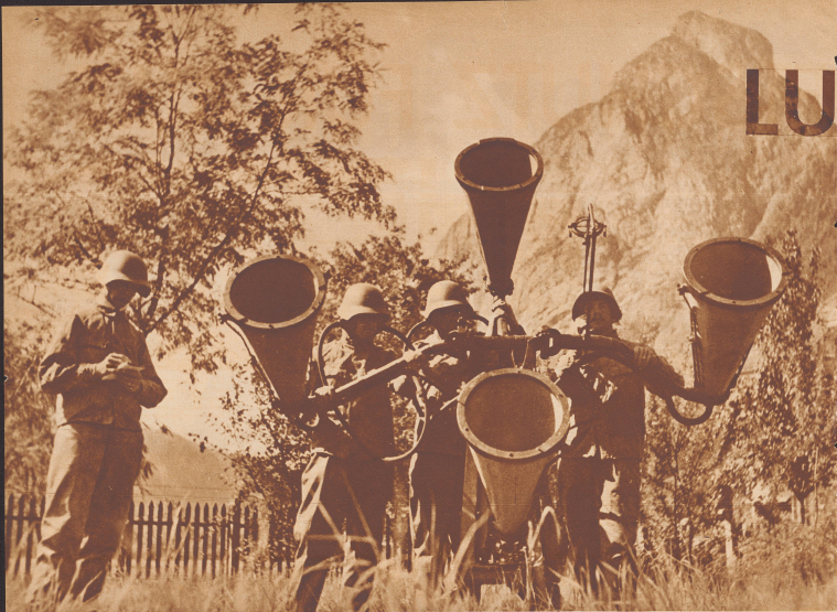
Hochgerät, das jetzt in der Armee neu eingeführt wurde. In der Kriegszeit sind alle wichtigsten Beobachtungsposten mit dem Apparat ausgestattet. Er ermöglicht es, Motorengeräusch auf 150 bis 200 Kilometer Distanz wahrzunehmen und so das Herannahen feindlicher Flugzeugformationen, lange bevor sie sichtbar sind, her Beobachtungsposten mittels dieser seine Warnmeldung an die Alarmposten weiter, dem setzen die Sirenen in Tätigkeit, und die Bevölkerung weiß, daß sie sich in den Luftschutzraum begeben muß.
