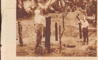
Bei der Errichtung neuer Sozialgebäude hilt Dr. Schweizer an sein eigenes reiches und Baumeister tüchtig mit. Hier setzt er Pläne, die eine Höhe zeigen sollen. Ein schwerer Patient hilt ihm.
