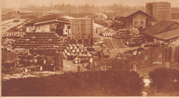
So sah das Bohr-«Olefeld» im Jahre 1931 aus. Die Tankbehälter reihen sich in einem Gewirr von Holzschuppen und Feuerzügen, primäre Holzbohlen umfassen den Platz, der einem alles andere als repräsentativen Eindruck macht.
