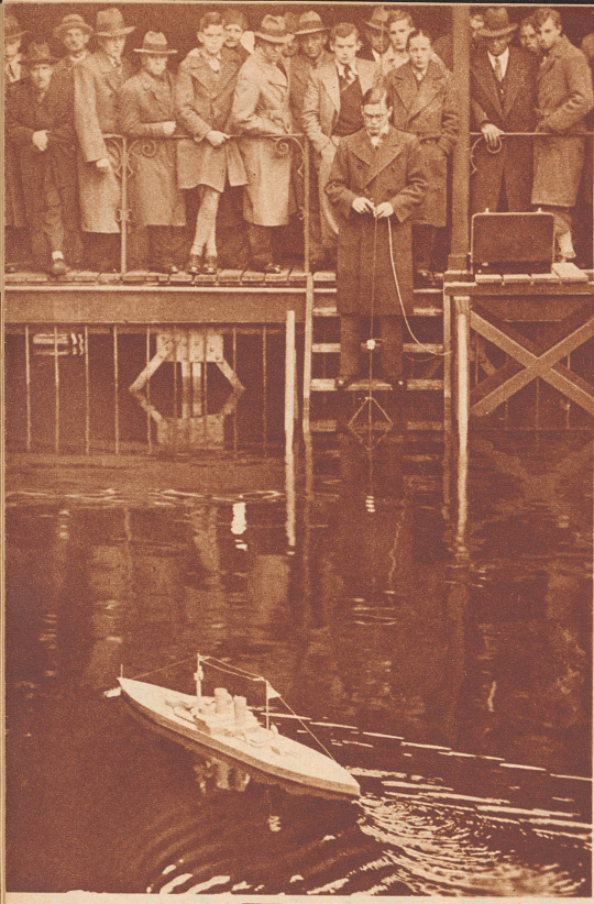
Das Schiffsmodell wird von dem jungen Manne auf der Treppe des Wasserbassins ferngesteuert. Rechts von ihm steckt in dem Kofferchen der Telegraphie-Sendeapparat. Vor dem Manne steht die 4 Meter lange Sendeantenne. Er hält in der Hand eine Telefon-Nummernscheibe. Je nach der Nummer, die er einstellt, bewegt sich das Schiff vor- oder rückwärts, langsam oder schnell.
