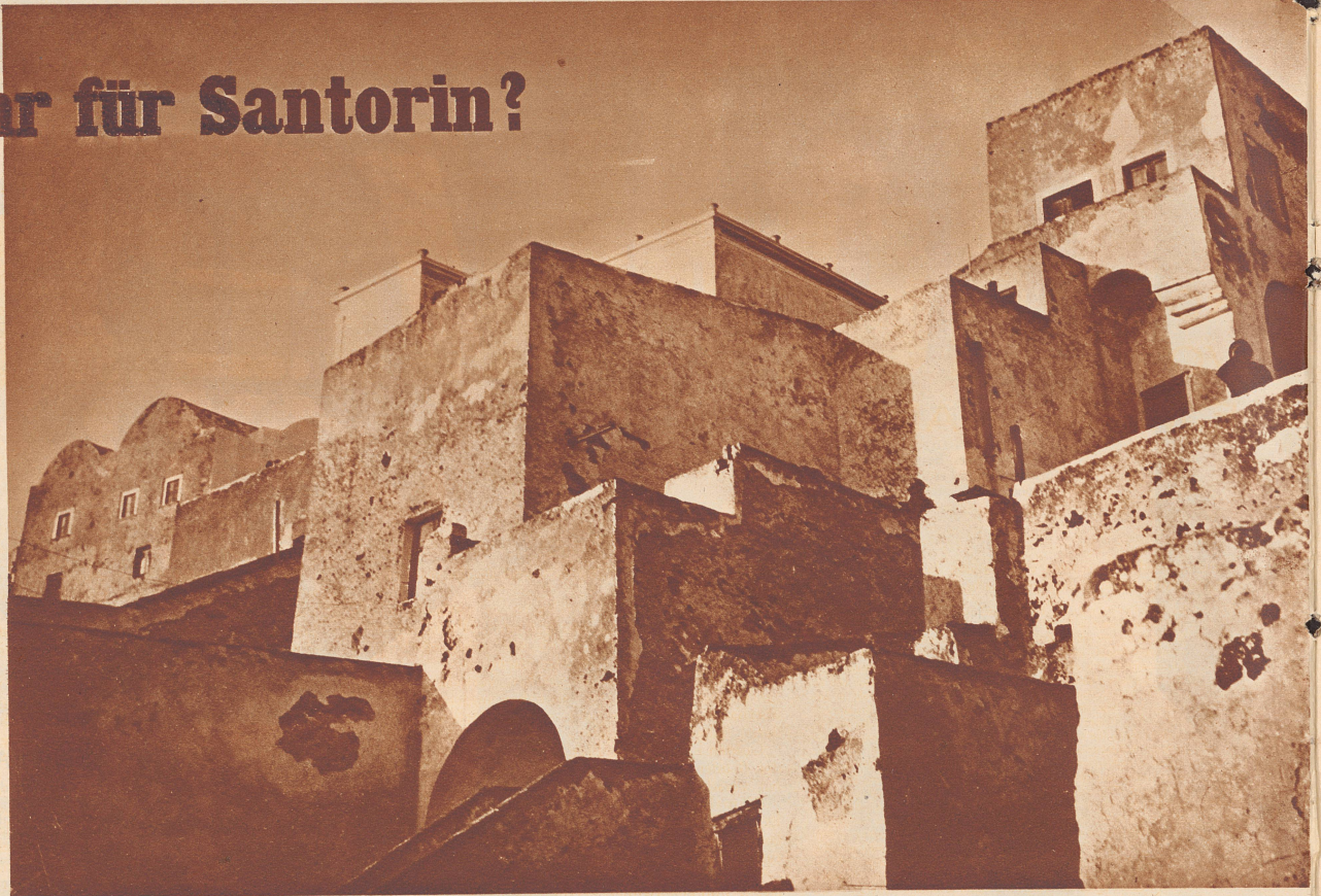
Häuser in Phira. Sie sehen aus wie Kassenschränke und sind auch so fest wie diese, denn sie sind aus steinharter Porzellanerde erbaut, damit sie den häufigen Erdbeben, die diese Gegend heimsuchen, standhalten.
