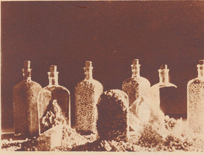
Quellende Erbsen vermögen dickwandige Glasflaschen zu sprengen. Das Wasser dringt ins Innere der Erbsen ein, mit unwiderstehlich wachsendem Druck pressen die immer größer werdenden Kugeln gegen das feste Glas, bis dieses nachgibt und bricht.
