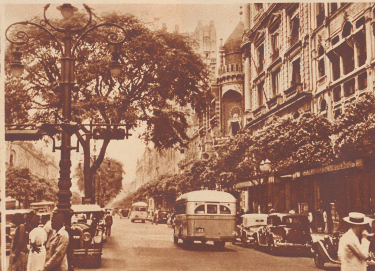
Avenida Rio Branco, die Hauptgeschäftsstraße der Millionenstadt. Hier stehen die Banken, die Theater, die Klubs, die größten Hotels, die Warenhäuser. Die ausgelassenen Automobile, die gesamte palisadierte Verkehr erinnert an einen Pariser Boulevard.
