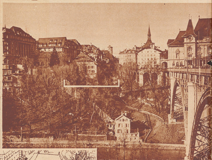
Blick von Süden auf den heutigen Gerberngraben. Links das Bellevue-Palace-Hotel, rechts das Kasino. In der Mitte die alten Bauten, die der Umgestaltung weichen müssen. Auf den 1. Mai müssen die Häuser geräumt werden, dann beginnt der Abbruch.
