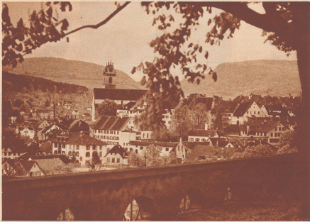
Ein Rückblick auf Aarau von der «Schanz» an der Schönwälderstrasse aus. Aus dem Dächergezwirr der westlichen Altstadt ragt die Stadtkirche, ein spitzgiebeliger Bau. Der Turm ist im 17. Jahrhundert mit einer Barockkuppel versehen worden.
