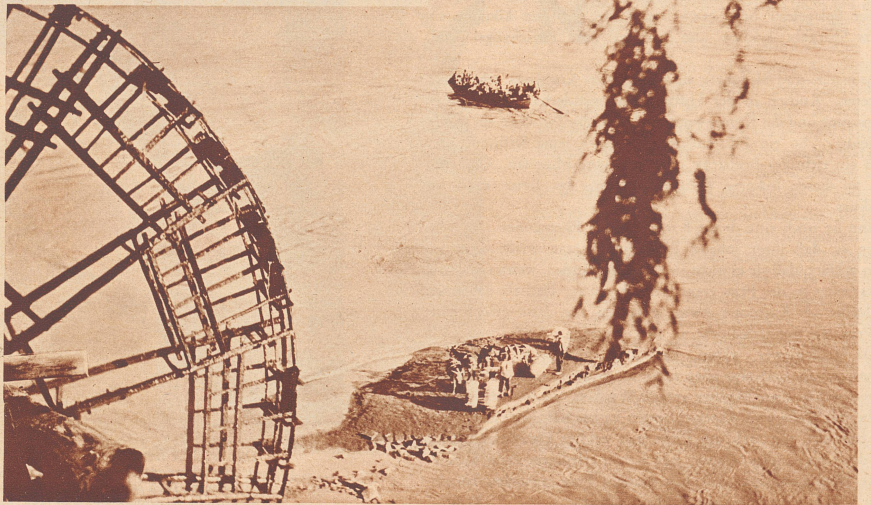
Wasserschöpfrad am Oberlauf des Hwang-Ho. Mit solchen kunstvoll gebauten Holzrädern von über 10 m Durchmesser wird das Wasser zur Bewässerung der Kulturen aus den Flüssen auf die höhergelegenen Terrassen befördert. Seit uralter Zeit vollzieht sich die Bewässerung in vielen Gegenden Chinas immer auf diese primitive Art: mit Menschenkraft wird das Riesenrad angetrieben, in Holzbehältern, die an der Peripherie des Rades angebracht sind, wird das Wasser im Fluß gefaßt, durch Drehung des Rades 10 m in die Höhe transportiert, dort in ein Bassin entleert und durch einen Holzkanal zu den Pflanzungen geleitet.
