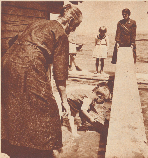
Notstegebau in einer Straße von Ermatingen.
