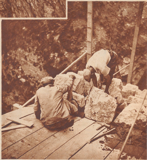
In schwindelnder Höhe arbeiten die Maurer. Stein an Stein wird zu- rechtgerückt, bis jeder genau seinen Platz gefunden hat. Die schmalen Lücken werden mit Mörtel verbunden, damit keiner der steinernen Keile herausfällt, wenn die Bretterunterlage abgebrochen wird.
