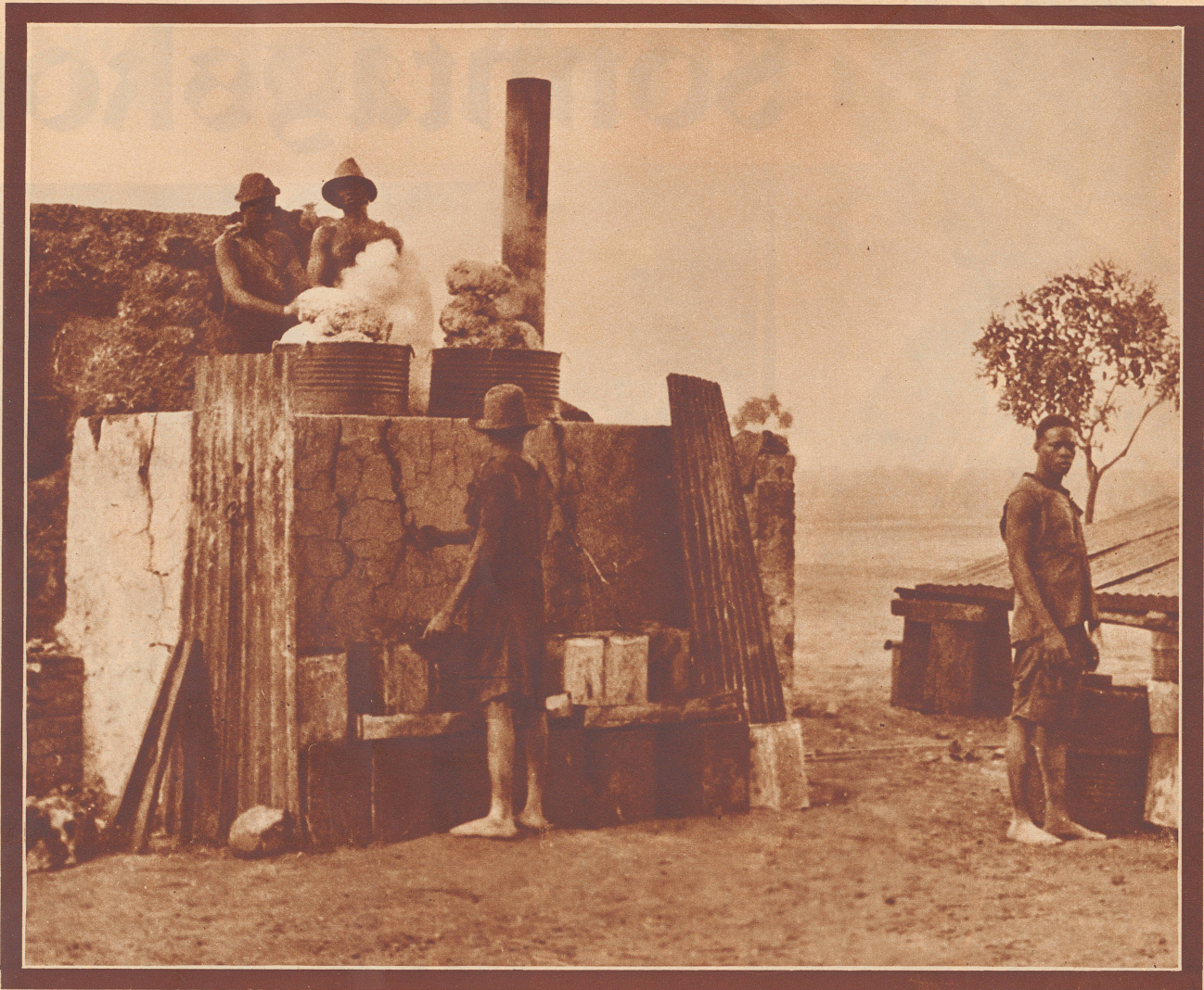
Schmelzofenanlage zur Gewinnung von Palmbutter an der Elfenbeinküste. Alles ist sehr primitiv eingerichtet. In eisernen Kesseln werden die gerösteten, zu Ballen gepressten Palmenkerne zum Schmelzen gebracht. Die durch dünne Rohre abfließende Palmbutter wird in alte Benzinkannen gefasst und nachher in transportfähige Eisenfässer abgefüllt.
