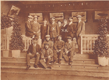
Das Betriebspersonal des Luftschiffes «Stadt Luzern». (x) Direktor und Chefpilot F. Altwald aus Paris, (y) Ingenieur Fritz Bell, Luzern, Bauleiter der Luftschiffhalle und Chef der Start- und Landungsmannschaft.
