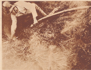
Die Feuerwehr an der Arbeit an einem durch Selbstentzündung in Brand geratenen Heustock. Die Feuerwehrmann links des Wasserstrahl direkt in den Brandherd, damit die übrige Löscharbeit von dem diesem entweichenden Rauch befreit wird und weiter arbeiten kann.
