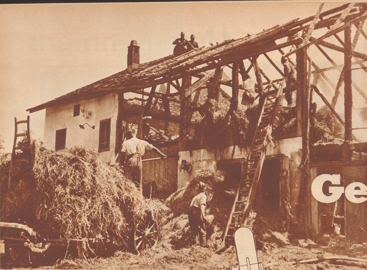
Ein Beispiel von vielen: Der Brandfall durch Selbstentzündung des Heustockes am 8. Juli 1935 in Wetzikon (Zürich). Der Brand im großen ist gelblich. Die Feuerwehr ist daran, den in Brand geratenen Heustock vordringlich mit Wasser zu löschen. Die Feuerwehr hat die Aufgabe, den Heustock zu löschen, um die Brandursache festzustellen. Das vom Stock herabgeworfene Heu ist natürlich ganz durchnässt. Es wird auf Wagen fortgeführt und in dem umliegenden Wiesen zum Trocknen ausgebreitet. Es ist nur noch als Stroh verwertbar.
