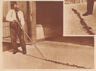
Die mit der Sonde ausgetrochene Probe wird mit Hilfe eines Holzkubes ausgetrennt. Die Probe besteht aus einem stark zusammengepreßten wasserfeuchten Gebilde aus Heu.
