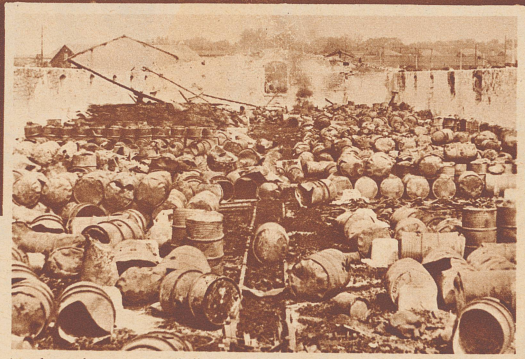
Total ausgebrannter Petrolkeller. Mehr als 1000 Oelfässer lagerten in dem Raum. Alle sind explodiert. Im ganzen sind 50 000 l Petrol, 6000 kg Benzol und 5000 l Benzin verbrannt.
