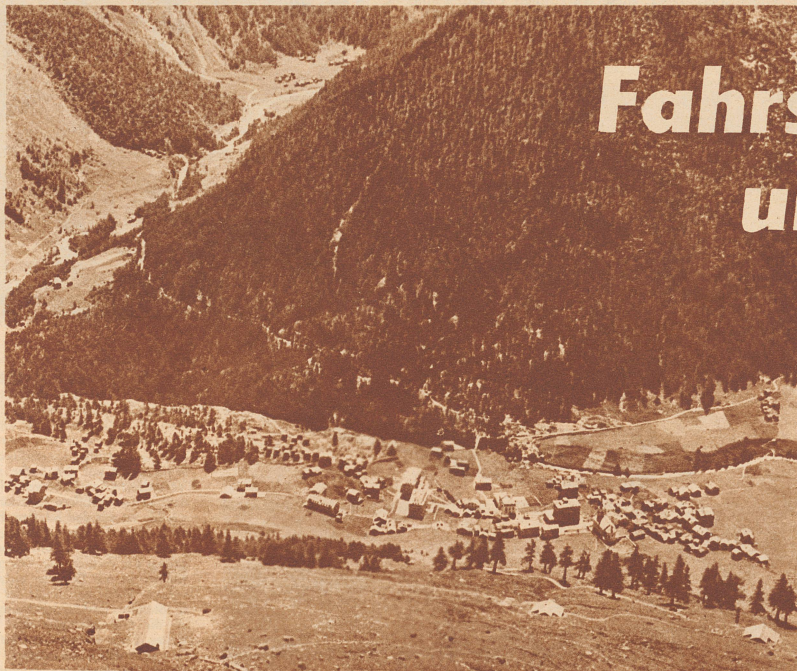
Das langgezogene Bergdorf Saas-Fee. Links auf dem Bilde ist ein Saumweg, der zu dem tiefer liegenden Häusergrüpplein des Dorfes führt. Hier wird voraussichtlich die im Bau befindliche Straße ein Ende haben.
