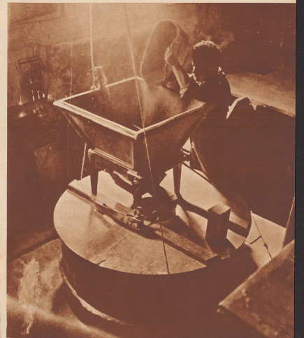
Im Innern der Mühle im oberen Stock, dort wo das Korn eingeschüttet wird. Es geht ohne Dynamo und ohne Transmissionen, ja fast ohne Eisen. Da meinet in Stein und Eisenholz. Draußen pumpt das Wasser über große Lauf. Ja, die Zahne des 80 Zentner schweren Wellenbaums sind aus Holz geblieben. Kein Ölpropfen, keine Purzwelle, ein bodenständige Werk in tiefstem Sinne des Wortes.
