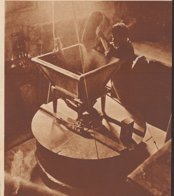
Im Innern der Mühle im obern Stock, dort wo das Korn eingeschüttet wird. Es geht ohne Dynamo und ohne Transmissionen, ja fast ohne Eisen. Das meiste ist Stein und Eichenholz. Draußen plätschert das Wasser übers große Rad. Ja, die Zähne des 80 Zentner schweren Wellenbaums sind aus Holz gehauen. Kein Oeltröpfchen, keine Putzwolle, ein bodenständiges Werk im tiefsten Sinne des Wortes.
