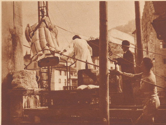
Vollständig eingepackt und gut gepolstert wird die 1½-Tonnen schwere Figur mit einem Flaschenzug von dem alten Standort gehoben und mit einem Rollwagen ins Museum transportiert.
