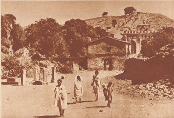
Der alte Krönungsplatz und eine von Menelek erbaute Kirche von Aksum. Archivfoto P. 1911
