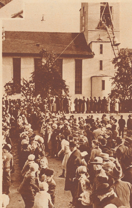
Die Glocken konnten nicht wie üblich von den Schulkindern senkrecht in die Höhe gezogen werden, weil ein Vorbau am Turme im Wege stand. Man mußte eine schiefe Gleitfläche aus langen Balken erstellen, auf denen die Glocken dann in die Höhe glitten. Es ging aber auch so ganz gut.
