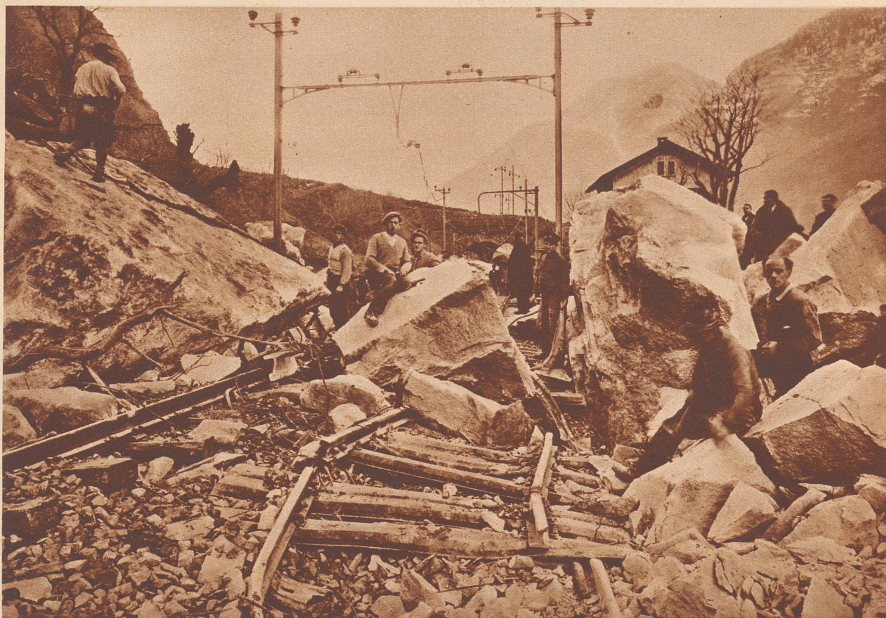
Durch Blöcke von vielen Tonnen Gewicht wurden die Schienen wie Zündhölzer zerbrochen, verbogen und verschoben. Viele dieser riesigen Blöcke mußten durch Sprengung und mit Kranen entfernt werden.
