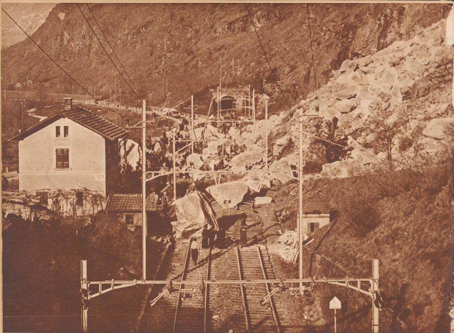
Blick auf die Absturzstelle. Mehrere hundert Kubikmeter Felsmassen und Schutt liegen auf dem Bahnkörper und auf der Straße. Menschen sind durch den Absturz nicht zu Schaden gekommen. Die Fahrleitung der Gotthardbahn und das Geleise sind schwer beschädigt. Außerdem wurde ein Bahnwärterhäuschen zerstört.
