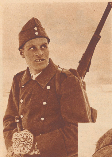
Wachmeister Jauch, Göschenen, von der Gebirgsinfanterie-Kompagnie I/87, 24 Jahre alt. Er ist Leitungskontrolleur des Elektrizitätswerkes Lavorgo und hat als solcher alle 14 Tage die Leitung auf der Strecke Amsteg-Lavorgo von Mast zu Mast zu kontrollieren. Wer die Führung dieser Leitung durch das Reußtal und über das Urserental kennt, wird verstehen, daß Wachmeister Jauch jederzeit gut im Training ist.
