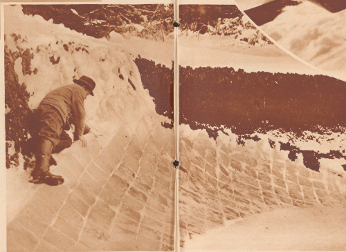
Kurvenmauerung mit Eisriegeln an der Olympiabobbahn in Garmisch-Partenkirchen.
