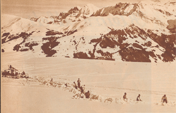
Gebirgsinfanterie beim Ausheben eines Schützengrabens im Schnee. Zum Ausheben werden Schaufeln verwendet, mit den Skiern werden die Breitreifen festgegraben. Sobald der Ausbau vollendet ist, wird die jetzt oberhalb abgesetzte Ausrichtung in den Graben herangezogen.
