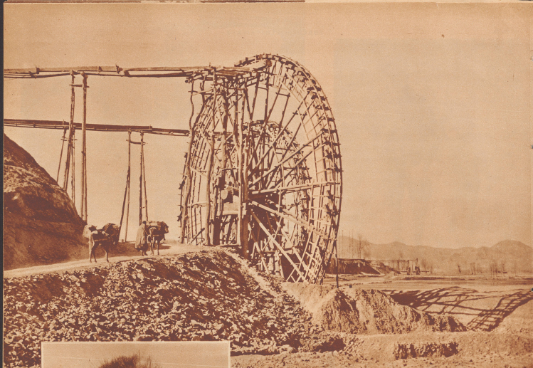
Wasserrad bei Nantah am Gelben Fluß auf dem Wege nach Sining. Mit solchen kunstvoll gebauten Holzrädern von oft über 10 Meter Durchmesser wird das Wasser zur Bewässerung der Reis-, Getreide- und Hirsenkulturen aus den Flüssen auf die höher gelegenen Terrassen befördert. Seit uralter Zeit vertriebt sich die Bevölkerung in vielen Gegenden Chinas immer noch auf diese primitive Art mit Menschekraft und die Rad angezogen in Holzbooten, die an der Peripherie des Rades aufgehängt sind, wird die Wasser im Fluß gefüllt, durch Drehung des Rades 10 Meter in die Höhe gehoben, dort durch einen Holzkanal in ein Bassin geleitet und von hier zu den Pflanzungen geleitet.
