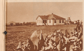
Das Haus des Managers oder obersten Betriebsleiters Schmid. Es enthält alle Einrichtungen, an welche der Europäer von heute sich gewöhnt hat und die er nicht gerne missen will. Ein Benzolmotor erzeugt den elektrischen Hausstrom. Dem obersten Betriebsleiter stehen etwa ein halbes Dutzend seiner jungen Schweizer als Helfer zur Seite. Es stehen große Sonnen auf dem Spiel. Jeder Fehler, jede Unzulänglichkeit haben Folgen, die große Anstände anrichten. Die schwarzen Arbeiter sind zwar willig, aber sehr Antsche in seiner Weise.
