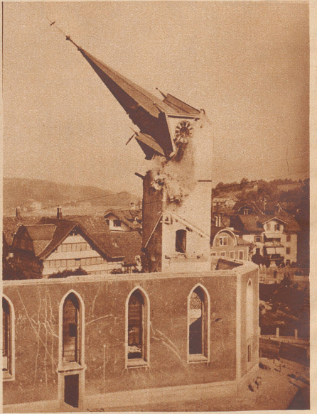
Nachdem die katholische Kirche von Herisau 57 Jahre alt geworden ist, wird sie jetzt niedergelegt, um durch eine größere ersetzt zu werden. Vergangenen 20. Juni nun war für den Turm das letzte Stündchen gekommen. Er wurde gesprengt, und zwar etappenweise, weil der in unmittelbarer Nähe liegende Tunnel der Appenzellerbahn und die nächsten Häuser eine größere Sprengung nicht ratsam erscheinen ließen. Bilder von links nach rechts: Um das Wegschleudern der Steine zu verhindern, wurde der Turm an der Stelle, wo die Sprengladung eingelegt war, mit Tannästen verkleidet. Die erste Ladung war nicht stark genug, um den ganzen Turm zum Einsturz zu bringen, der Helm blieb noch stehen und wurde später mit einem Drahtseil zu Fall gebracht. Aufnahmen Bauw
