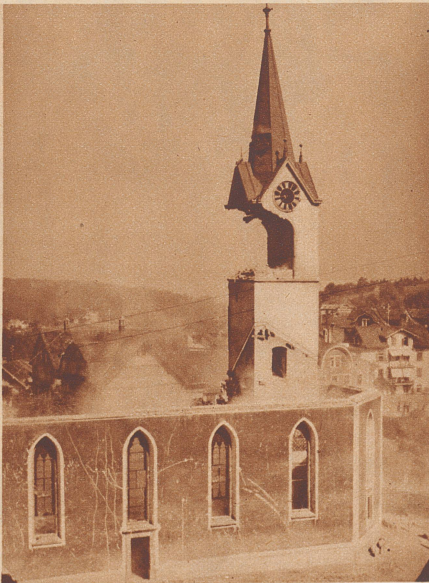
Nachdem die katholische Kirche von Herisau 57 Jahre alt geworden ist, wird sie jetzt niedergelegt, um durch eine größere ersetzt zu werden. Vergangenen 20. Juni nun war für den Turm das letzte Stündchen gekommen. Er wurde gesprengt, und zwar etappenweise, weil der in unmittelbarer Nähe liegende Tunnel der Appenzellerbahn und die nächsten Häuser eine größere Sprengung nicht ratsam erscheinen ließen. Bilder von links nach rechts: Um das Wegschleudern der Steine zu verhindern, wurde der Turm an der Stelle, wo die Sprengladung eingelegt war, mit Tannästen verkleidet. Die erste Ladung war nicht stark genug, um den ganzen Turm zum Einsturz zu bringen, der Helm blieb noch stehen und wurde später mit einem Drahtseil zu Fall gebracht. Aufnahmen Bauw
