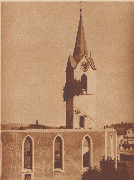
Nachdem die katholische Kirche von Herisau 57 Jahre alt geworden ist, wird sie jetzt niedergelegt, um durch eine größere ersetzt zu werden. Vergangenen 20. Juni nun war für den Turm das letzte Stündchen gekommen. Er wurde gesprengt, und zwar etappenweise, weil der in unmittelbarer Nähe liegende Tunnel der Appenzellerbahn und die nächsten Häuser eine größere Sprengung nicht ratsam erscheinen ließen. Bilder von links nach rechts: Um das Wegschleudern der Steine zu verhindern, wurde der Turm an der Stelle, wo die Sprengladung eingelegt war, mit Tannästen verkleidet. Die erste Ladung war nicht stark genug, um den ganzen Turm zum Einsturz zu bringen, der Helm blieb noch stehen und wurde später mit einem Drahtseil zu Fall gebracht. Aufnahmen Bauw
