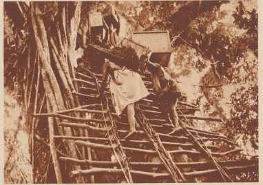
Um sie vor der Überflutung durch die Hochwasser der Regenzeit zu schützen, läßt der Brückenbauer-Urwaldmeister die Hängebrücken fünf Meter über den tiefsten Wasserstand des Flusses schütten. So die Lösser führen zum Brückenkopf empor, die den schwerbeladenen Trägern viel Schwere können.
