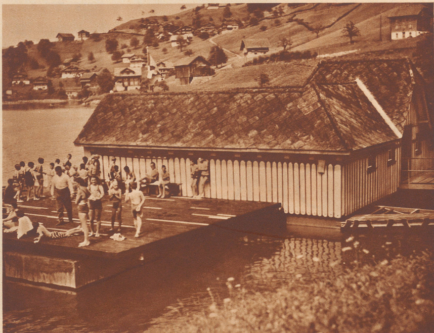
Die Badanstalt am Lungernsee im Monat Juli. Zur Zeit des Hochwasserstandes unterscheidet sie sich keineswegs von irgend einer andern Badeanstalt — es ist dann ein Badeplatz, wie es Dutzende an den Ufern der Schweizerseen gibt.
