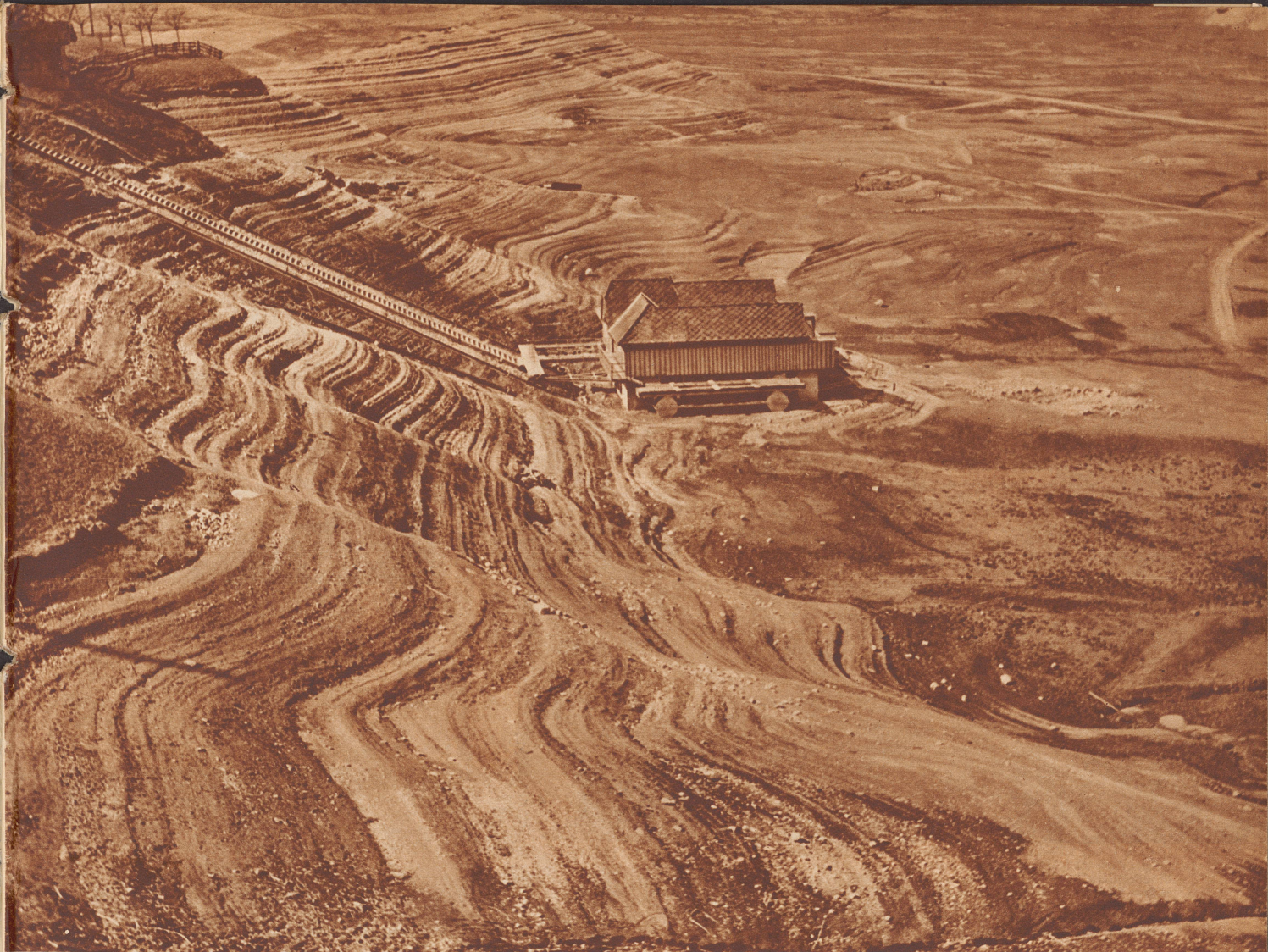
Die Badanstalt am Lungernsee während der toten Saison. Das Niveau des Sees hat sich um viele Meter gesenkt. Mit dem Seespiegel ist das Badehaus an der Ufertreppe in die Tiefe geklettert und sitzt nun auf dem fast ebenen Seeboden fest. Das Bild zeigt deutlich die eigenartige Schichtenbildung der Ufer, die von der nagenden Wirkung des Wellenschlages herrührt. Immerfort arbeiten die Wellen an den weichen Erdschichten, waschen sie aus und täuschen eine Dünenlandschaft vor.
