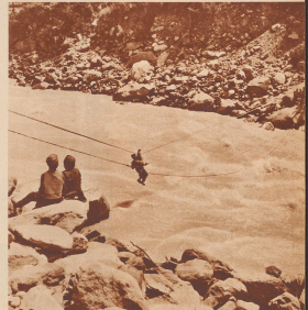
Kinstliche Liebesang eines Eingeborenen über den wilden Kalgrimmstief in der abgelegenen Nepal. Der Partner hängt an einem Holzpfahl am oberen Seil und wird von Ufer an ein unteres Seil am gegenüberliegenden Ufer gezogen. Un jeune prisonnier sur le Kali. L'indigène est assis sur un bloc de bois suspendu à la corde supérieure. Avec la corde inférieure, il se meurt vers la rive opposée.
