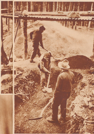
In einem Graben arbeiten, im Regenschnee einer improvisierten Wäldchenschneise, wird die Decke, die ganz trocken sein muß, für den Meiler vorbereitet. Sous un ciel impavide, on prépare soigneusement la terre qui servira à recouvrir le meiler.
